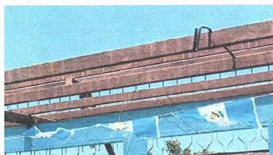
Foto 2: Mantenimiento a soporte de metal, aplicación de pintura anticorrosiva. En el modulo 1
