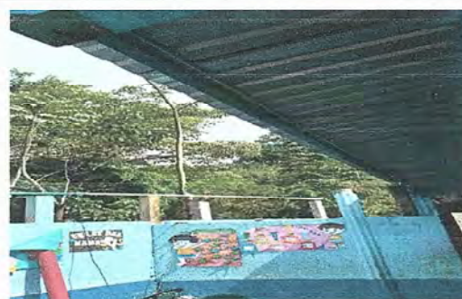
Foto 6: Sustitución de estructura de soporte de madera por costanera GLV 4X2 "16" en el tercer modulo
