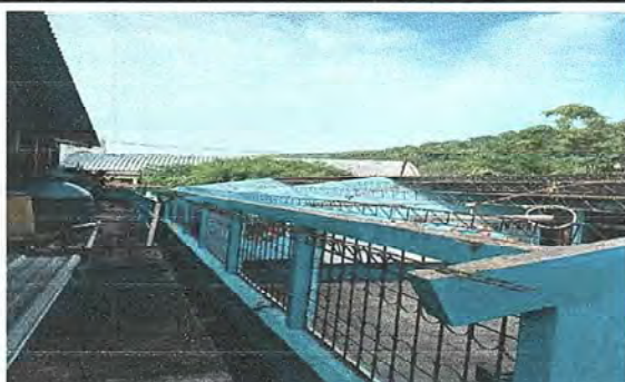
Foto 3: Sustitución de lamina, por lamina troquelada Aluzinc en el segundo modulo.
